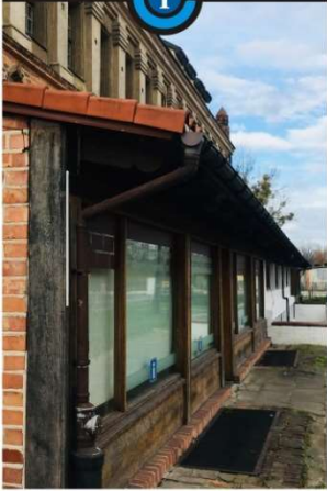
STAN PRZED REMONTEM
