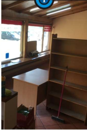
PRZYGOTOWANIA DO REMONTU
