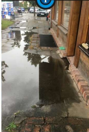
STAN PRZED REMONTEM
