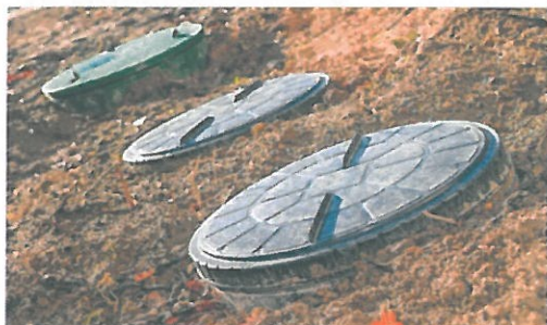
Budowa przydomowych oczyszczalni ścieków sanitarnych na terenie gminy Chojna - etap IV
