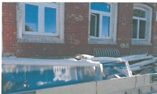
Termomodernizacja budynku Urzędu Miejskiego przy ulicy Jagiellońskiej w Chojnie.
