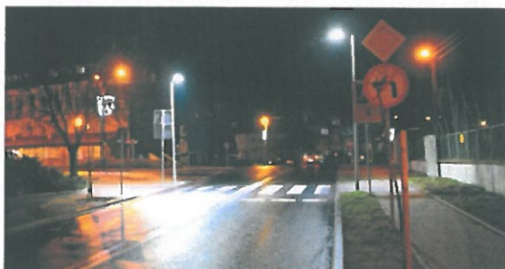
Budowa oświetlenia solarnego w gminie Chojna (przejścia dla pieszych).
