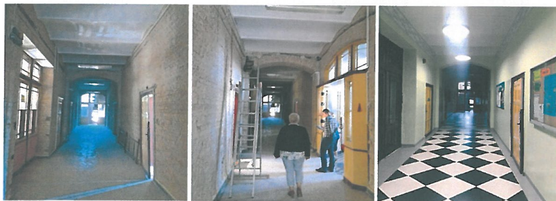
Modernizacja budynku Szkoły Podstawowej nr 1 w Chojnie.
