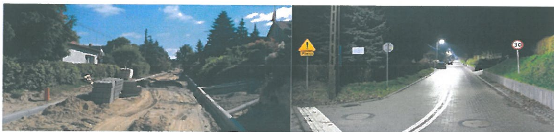
Przebudowa drogi gminnej wraz z budową kanalizacji deszczowej (ul. Zielona w Chojnie).
