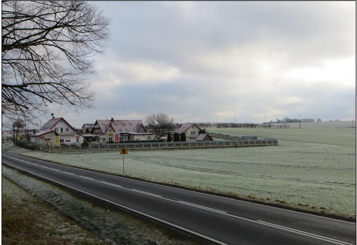
Foto 2. Ogrorzona i zabudowana współczesną zabudową działka nr 2001 objęta opracowaniem przy drodze krajowej nr 26 - ul. Szczecińska.(stan: styczeń 2015 r.)
