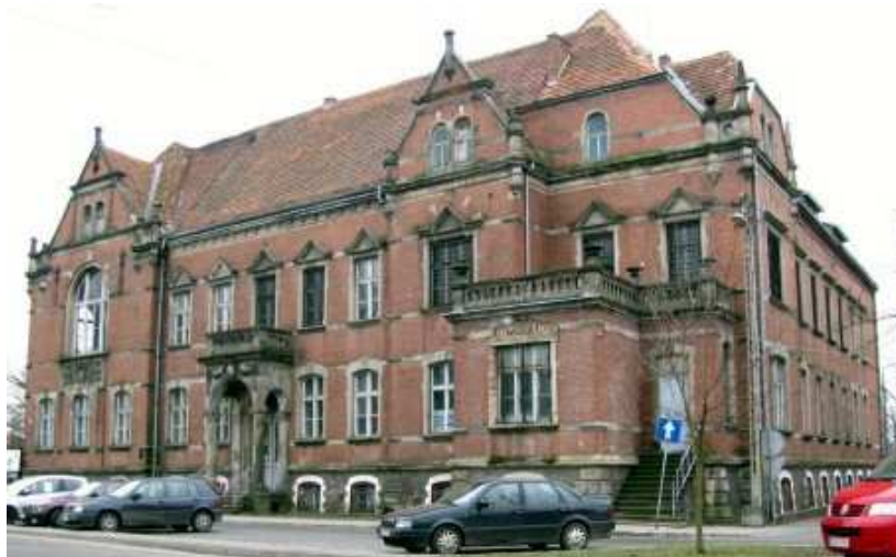
Zdjęcie nr 3 Obiekt zabytkowy położony w Chojnie przy ul.Kościuszki 21
