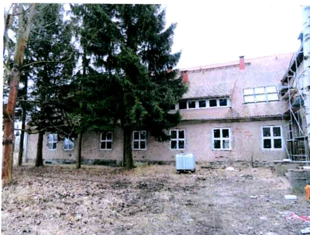
Fot. 5. Budynek, widok od strony zach.
