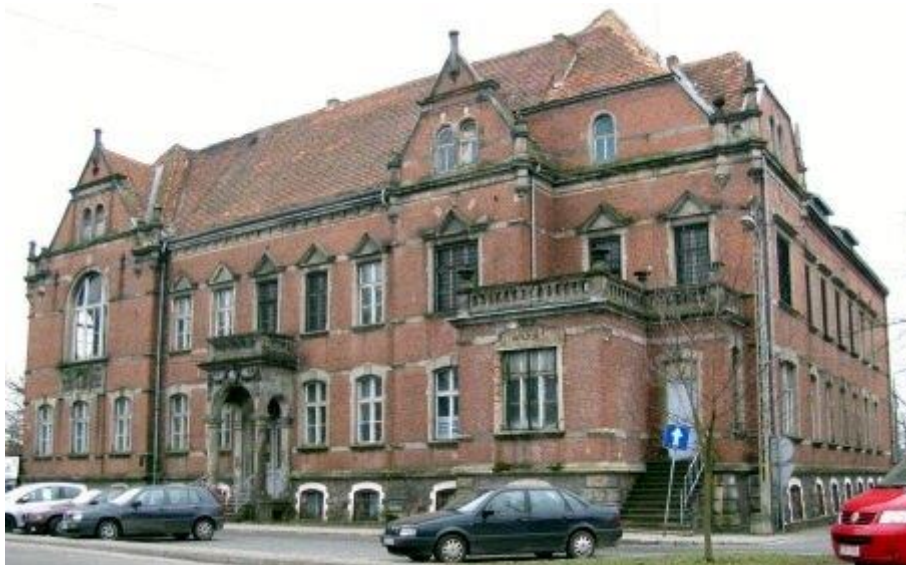
Zdjęcie nr 4 Obiekt zabytkowy położony w Chojnie przy ul. Kościuszki 21
