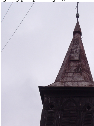
Wieża barokowego kościoła
